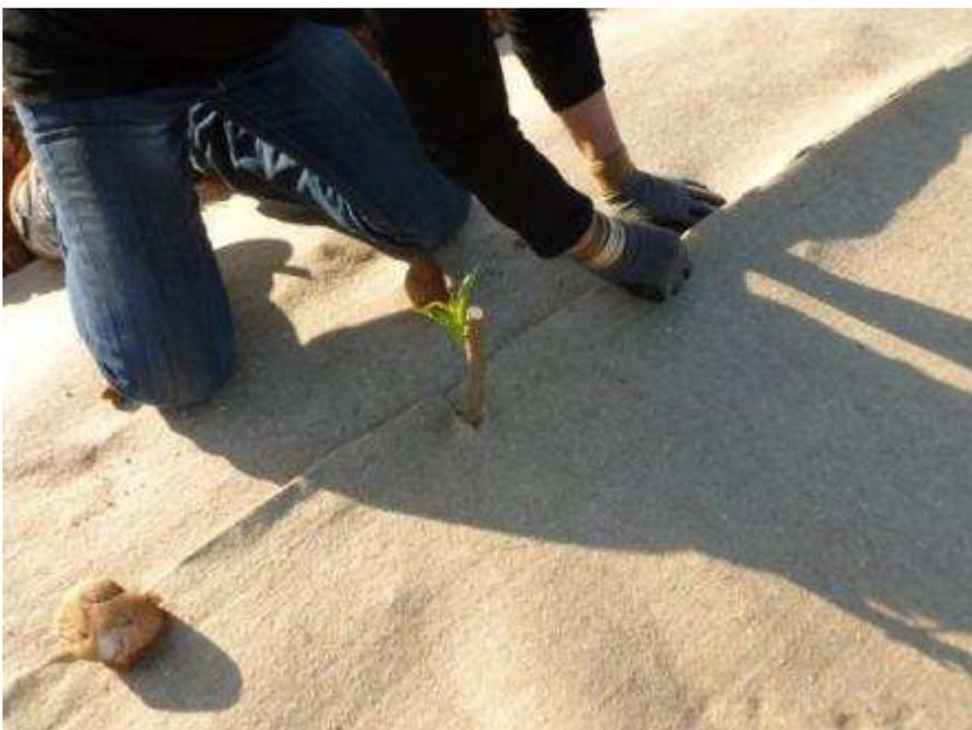
*Une fois bien positionnées, les laies de paillage sont calées par la dépose de galets pour éviter les soulèvements lors de périodes ventées.*
