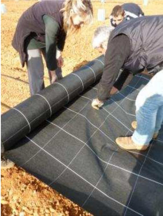
*Avec notre mise en place, nous boudinons la toile sur les côtés avant de la recouvrir. De fait on perd un peu de largeur couverte, ce qui laisse une bande plus large de sol à entretenir (tonte).*
